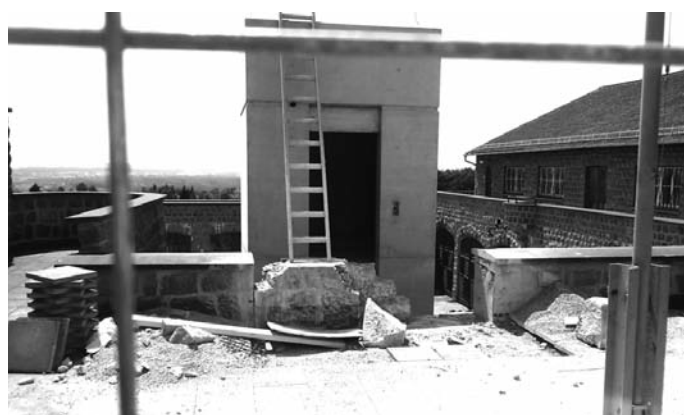
La torretta che contiene la tromba dell'ascensore: la partenza al piano terra e l'uscita al piano superiore.
