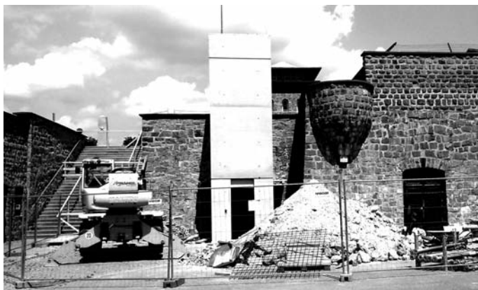
La torretta che contiene la tromba dell'ascensore: la partenza al piano terra e l'uscita al piano superiore.
