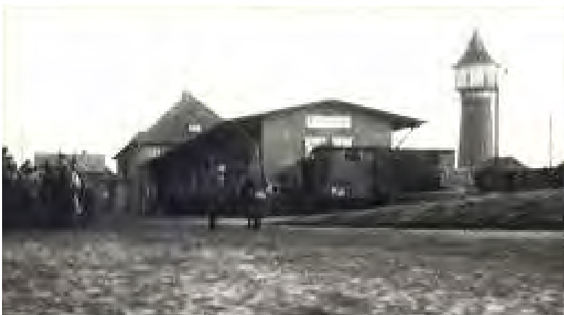
Stazione di Bremervörde. 1945.
