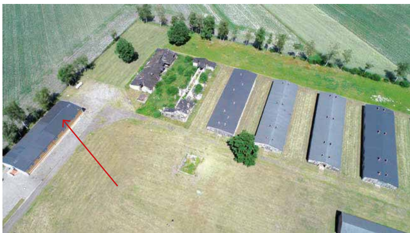
Lager di Sandbostel visto dall'alto. A sinistra l'edificio della mostra.
