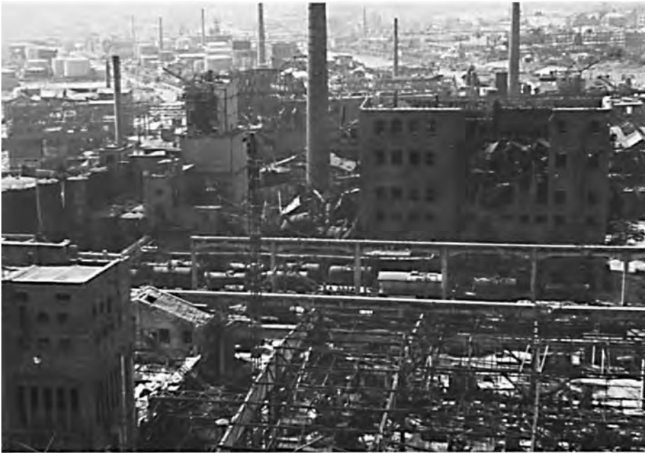
19. LA RAFFINERIA È SEMIDISTRUTTA.
