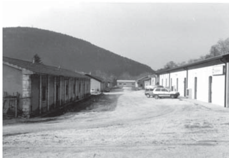
foto 13 - Ampii spazi fra le due file di edifici in muratura
