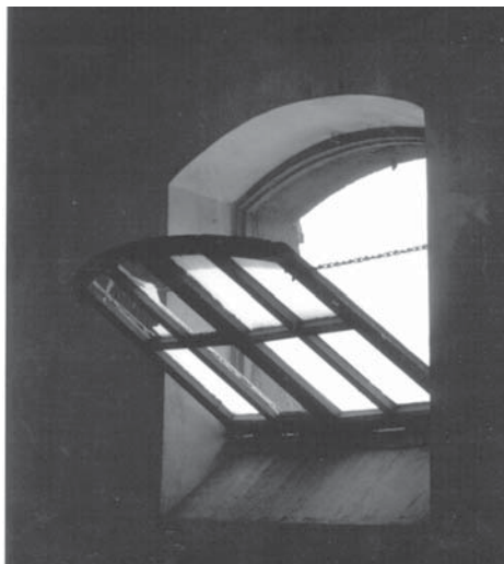
foto 4 - Particolare di una finestra delle camerette in muratura
