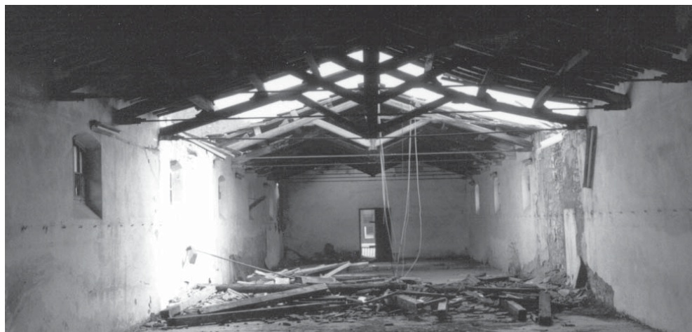
foto 5 - Interno di una casermette in muratura
