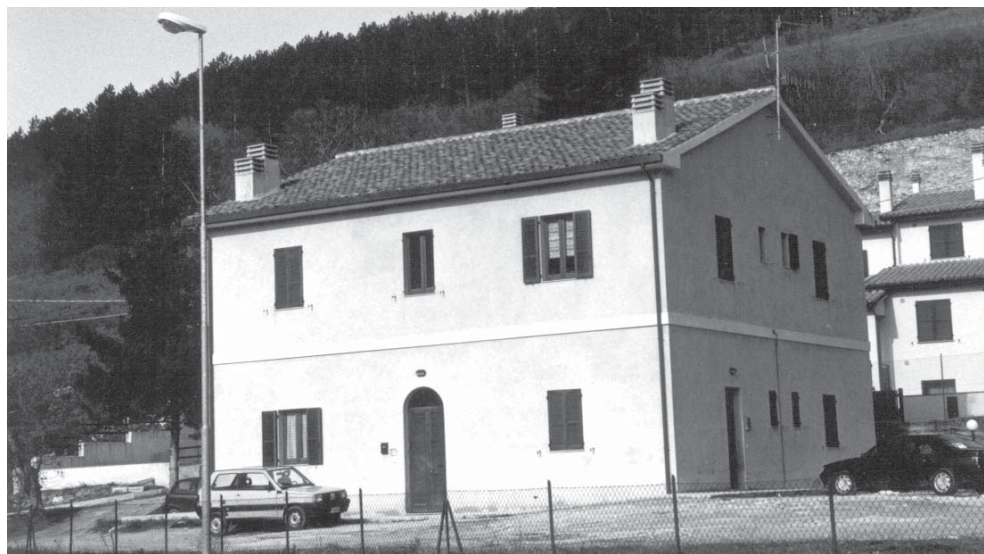
foto 14 - L'edificio in cui alloggiavano sottufficiali e truppa
