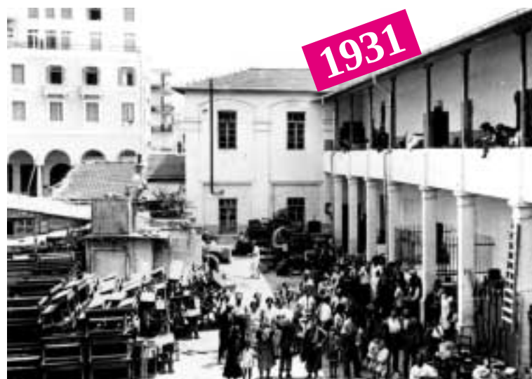
Un "pogrom" colpisce la comunità di Salonicco. Ecco una scuola svuotata delle attrezzature e dei mobili, scaraventati sulla strada.
