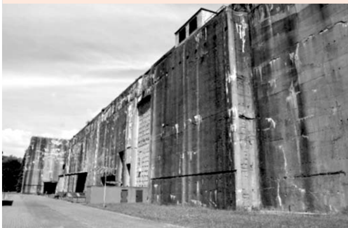
Il bunker “Valentin” per la costruzione di sottomarini, vicino a Brema, dove lavoravano, fianco a fianco, i deportati politici ed ebrei del campo di Neuengamme e centinaia di militari italiani.
