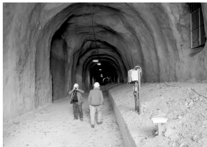
Un tratto visitabile delle gallerie oggi.
