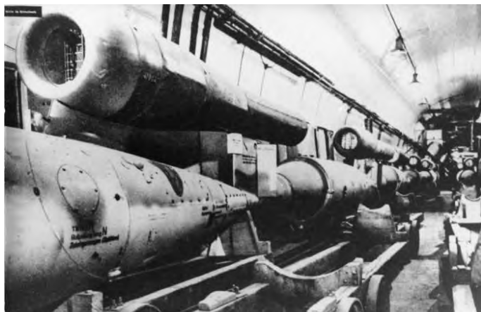
Qui sopra le V2 in fabbricazione nelle gallerie.
